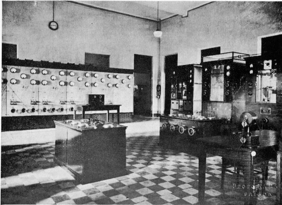
Centre d'émission de Phutho — Poste à quartz 15 kw FZR et FZS.
